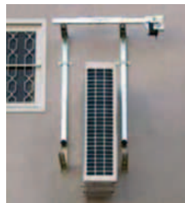
Paso 5: Esta es la manera correcta de pasar la máquina entre las escuadras
