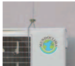
Paso 4: Tirar hacia abajo del cable acerado desde el travesaño, pasarlo por debajo de la máquina y engancharlo en el mismo cable. Levantar la máquina del suelo unos centímetros para poder equilibrarla antes de subirla
