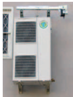
Paso 6: Apoyar la máquina sobre las escuadras de la pared y atornillar. Ya se puede desmontar la grúa
