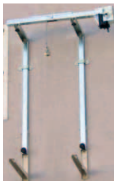
Paso 3: colocar el travesaño con la reductora sobre las escuadras y deslizar el cable acerado para atar la máquina
